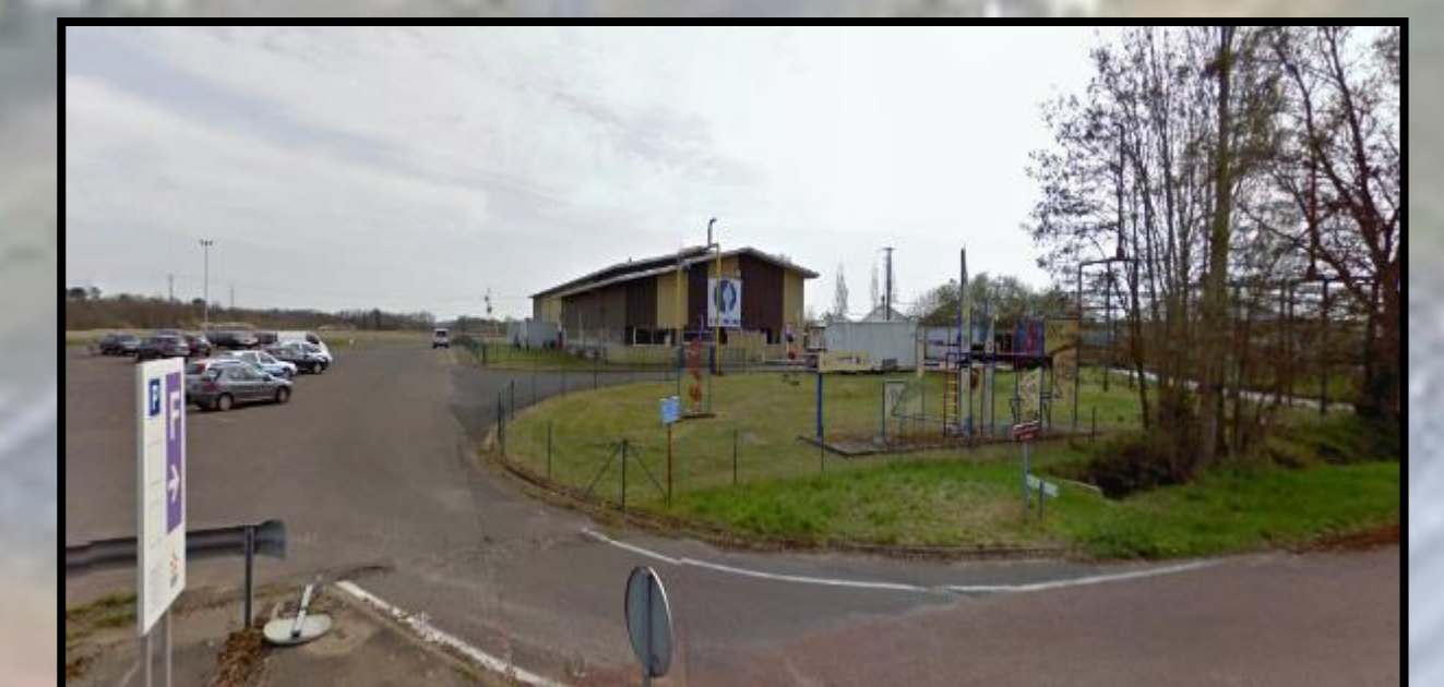
Zone industrielle voisine à la centrale
